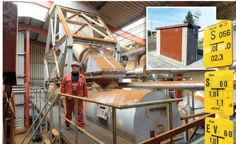
Über die neu gebaute Gasdruckregel- und Messanlage (kl. Bild) strömt das Erdgas in die Hallen der P. U. S. GmbH. Hier bringt es auch die Trockner für Eisenhydroxidfilterschlämme auf die richtige Temperatur.
