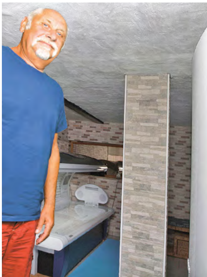
Nach der Umstellung – Hartmut Vater im blitzblanken Heizungskeller.
