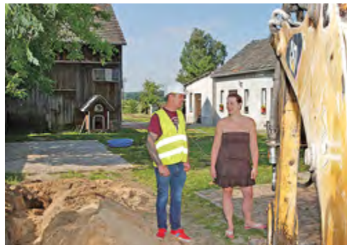
Bauleiter Frank Fritsche von der Firma PRT erklärt Annett Parakenings, wo das Erdgas ins Haus kommt.
