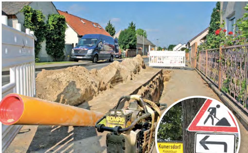
Abchnittsweise kommen die PE-Rohre unter die Erde.
