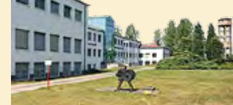
Neben dem alten Wasserturm wurde Platz für neues Gewerbe geschaffen.
