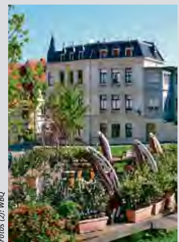
Auch in der Innenstadt hat die WBQ erstklassige Angebote – mit komfortabler Fernwärme.
